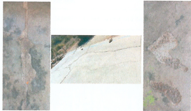
Foto 2: Mejoramiento y reparación de piso de aula, patio, dirección y bodega.
