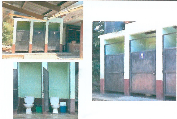
Foto 4: Mejoramiento e instalación de puertas y sanitarios.
